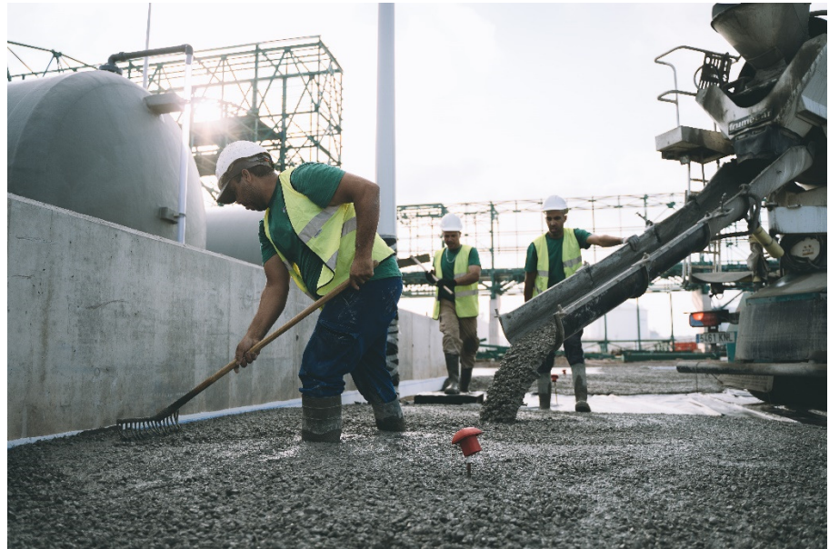
Detalle de la textura del hormigón con fibras suministrado.
