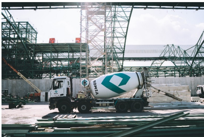
Detalle del interior de la obra.
