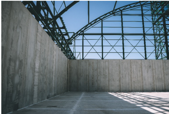
Vistas del interior de la nave.
