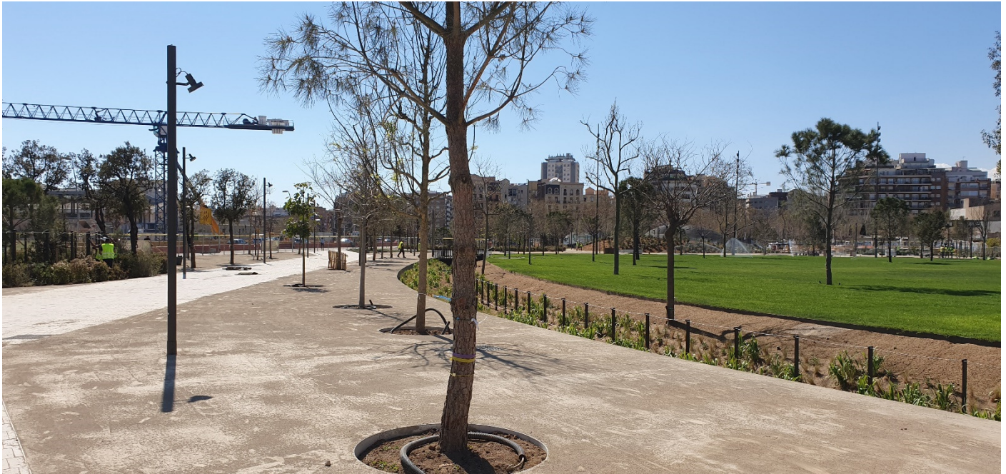
Vista del pavimento Aripaq en zonas peatonales en el parque de la Canòpia Urbana.
