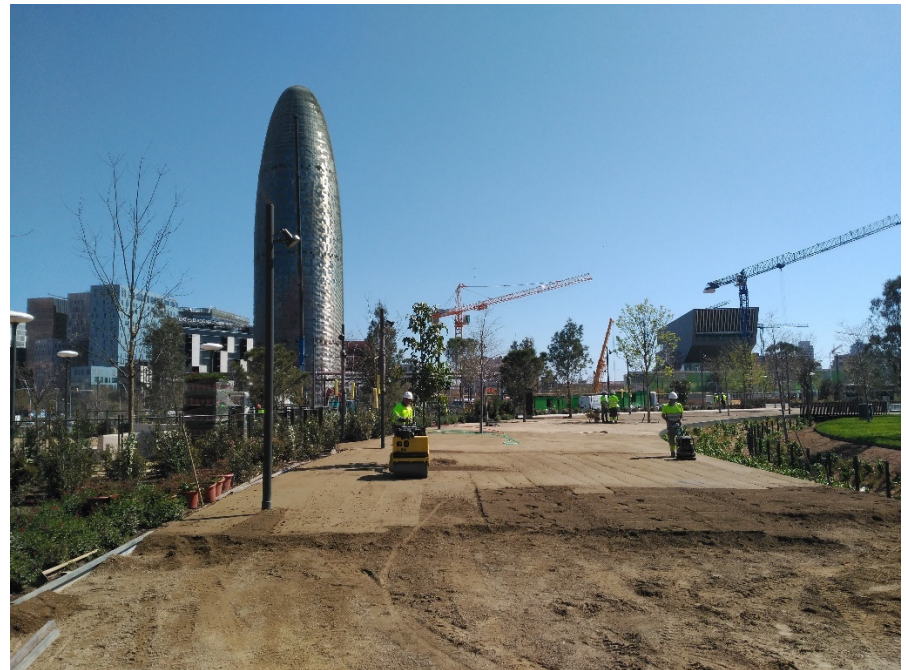
Aplicación de Aripaq en obra.
